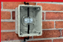
Messklemme des Blitzableiters
